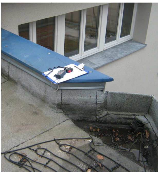
Fotografija: Streha in izliv pri manjši stekleni fasadi (levo) in streha z izlivom pri večji vzhodni stekleni fasadi (desno).
