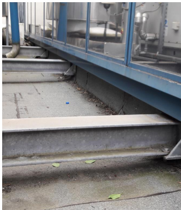
Fotografija: Terasa pri večji stekleni fasadi (levo) in nosilna kovinska podkonstrukcija klimatov (desno).
